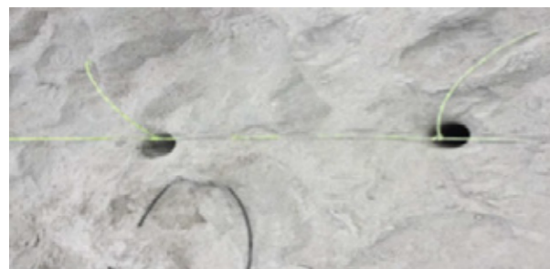
Overflateopptening med riktige knuter på hovedlunte.
