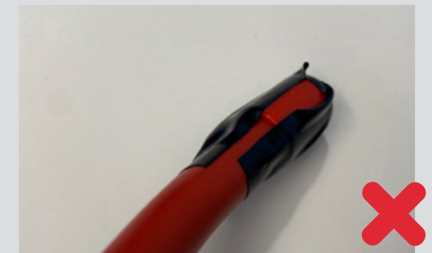
Lunte med dårlig teip trukket inn 10-15 cm vann.
