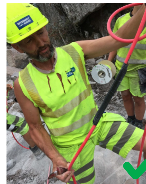
Skjøting av 100 g/m detonerende lunte med god overlapp.
