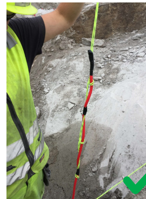
Riktig skjøt/kobling av detonerende lunte: Feste av 5 g/m lunte til lunte 100 g/m for sikker overføring. Enden på 100 g/m lunte er teipet for å gjøre den mer vannbestandig.
